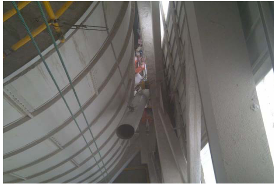
FIGURA 5.11 - ENSAMBLE DE DUCTOS PARA TRANSPORTE DE ARENA
