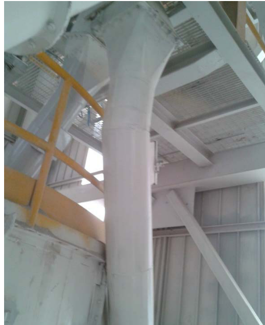
FIGURA 5.13 - ÚLTIMO TRAMO DE DUCTO ENSAMBLADO.
