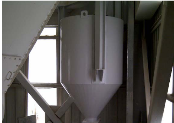
FIGURA 5.15 - SILO COMPLETAMENTE INSTALADO
