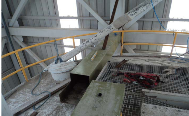
FIGURA 5.3 - PREENSAMBLE DE VIGA CAJÓN CENTRAL
