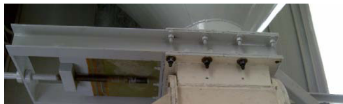
FIGURA 5.16 - VÁLVULA GUILLOTINA COMPLETAMENTE INSTALADO.
