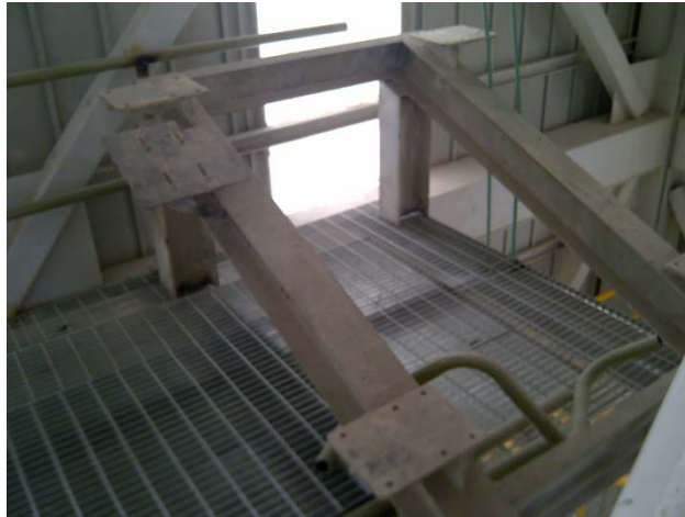
FIGURA 5.8 - BANCADA DEL EQUIPO VIBRATORIO CRIBA
