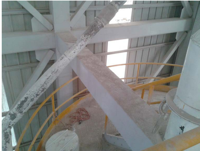
FIGURA 5.4 - VIGA CAJÓN CENTRAL FINALIZADA
