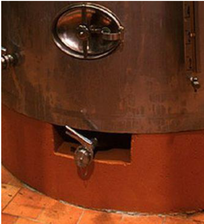
Figura: 2.0.16: Tanque de producto final
