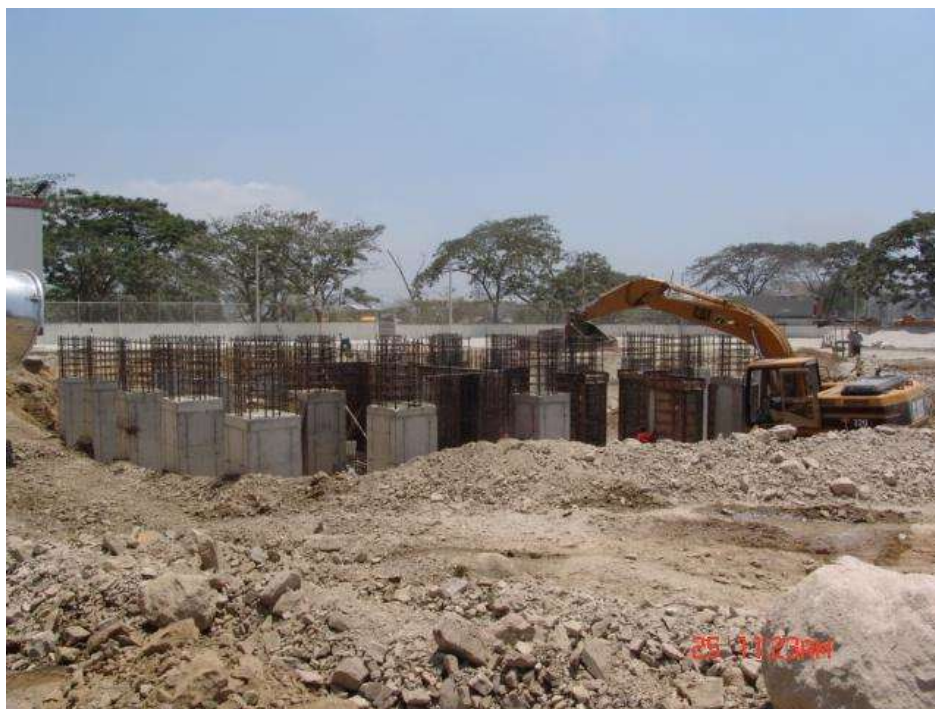
FIGURA 2.4: CIMENTACIONES PLANTA DE MORTERO SECO
