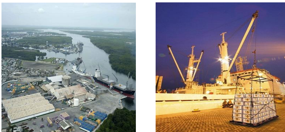
Figura 1.3 Terminal Portuario de Fertisa
