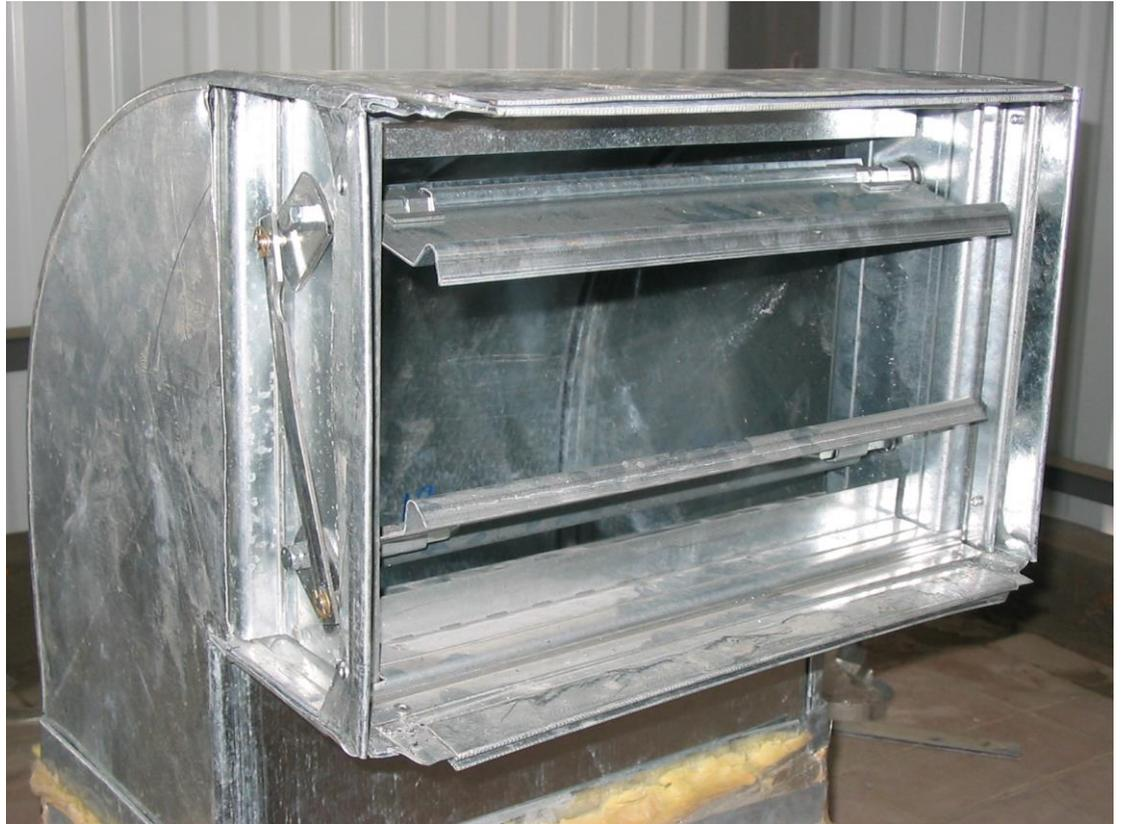
**FIGURA 3.2 DAMPER DE AIRE DE RETORNO**
