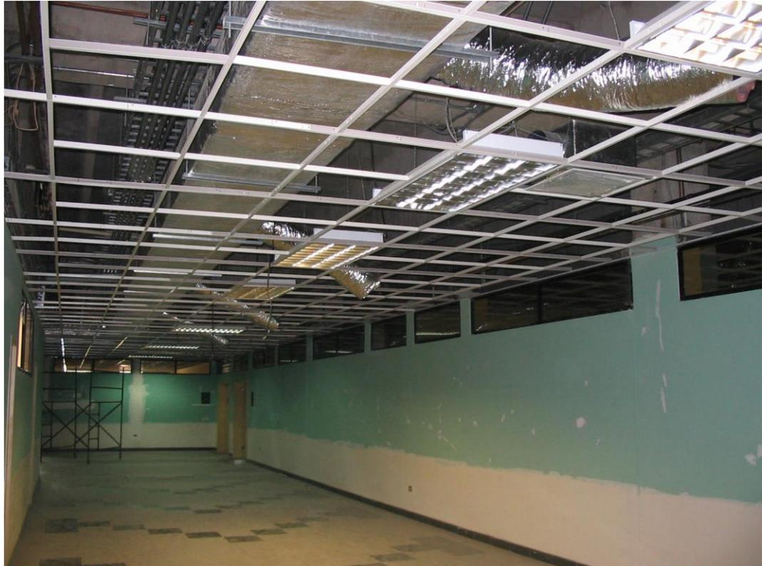
**FIGURA 1-1 TRABAJO EN DUCTOS, ILUMINACIÓN Y CABLEADO EN LA UNIDAD GINECOLÓGICA DEL HOSPITAL UNIVERSITARIO**
