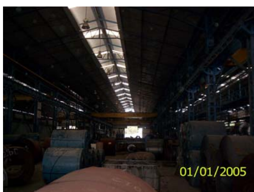
FIGURA 14. VISUALIZACIÓN DEL PUENTE GRÚA.
