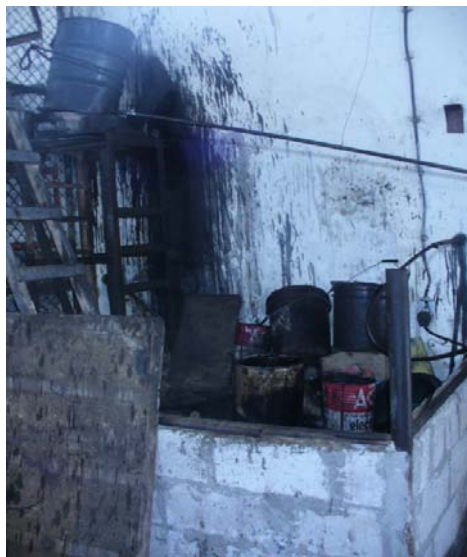
FIGURA 3.7 ALMACENAMIENTO INADECUADO DE PRODUCTOS INFLAMABLES
