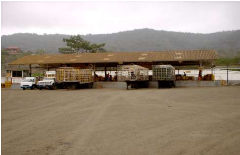
FIGURA 1.4 MUELLE DE CARGA Y DESCARGA DE CILINDROS
