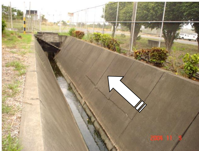
FIGURA 4.2 PRIMER TRAMO DEL CANAL CON SECCIÓN TRAPEZOIDAL
