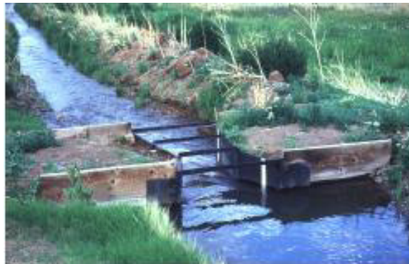
FIGURA 2.14 AFORADOR DE GARGANTA LARGA EN UNA ZANJA
