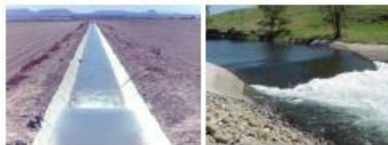
FIGURA 2.3 VERTEDEROS RBC EN CANALES DE IRRIGACION
