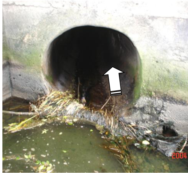
FIGURA 4.3 ENTRADA A LA ALCANTARILLA SUBTERRÁNEA
