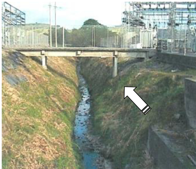
FIGURA 4.4 CANAL EXCAVADO EXTERIOR
