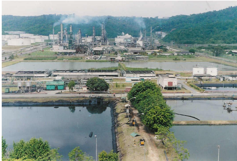
FIGURA 4.1. VISTA PANORÁMICA DE LA REE.
