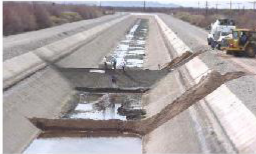
FIGURA 4.5 .Construcción en marcha de un vertedero de cresta ancha trapezoidal.
