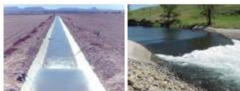
FIGURA 2.3 VERTEDEROS RBC EN CANALES DE IRRIGACION
