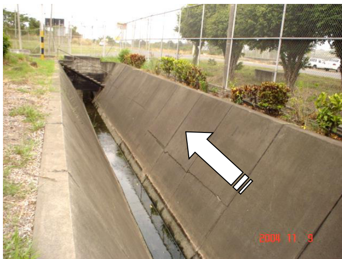
FIGURA 4.2 PRIMER TRAMO DEL CANAL CON SECCIÓN TRAPEZOIDAL
