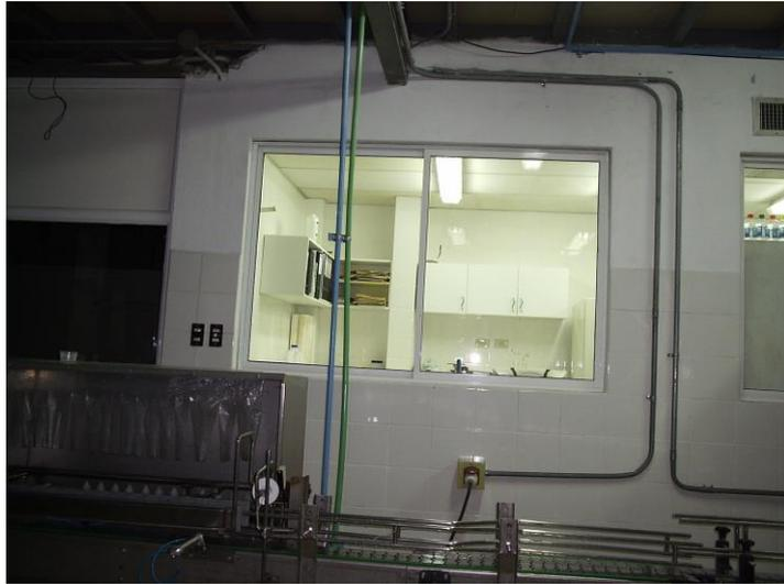
**FIG. 5.5c. TUBERIA E CONECTADO A CAJA DE PASO, Y CONECTADO A CLAVIJA QUE VA A TABLERO PRINCIPAL DE ALIMENTACIÓN.**
