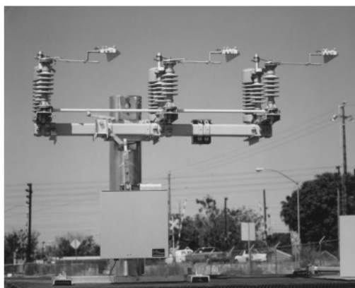
Figura 2.8: Seccionador remoto trifásico. [3]
