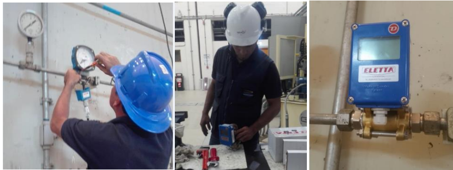
Figura 24. Instalación de Caudalimetro Serie D
