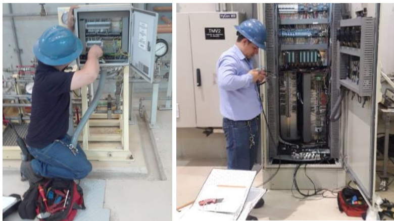
Figura 27. Paso de cables a tableros
