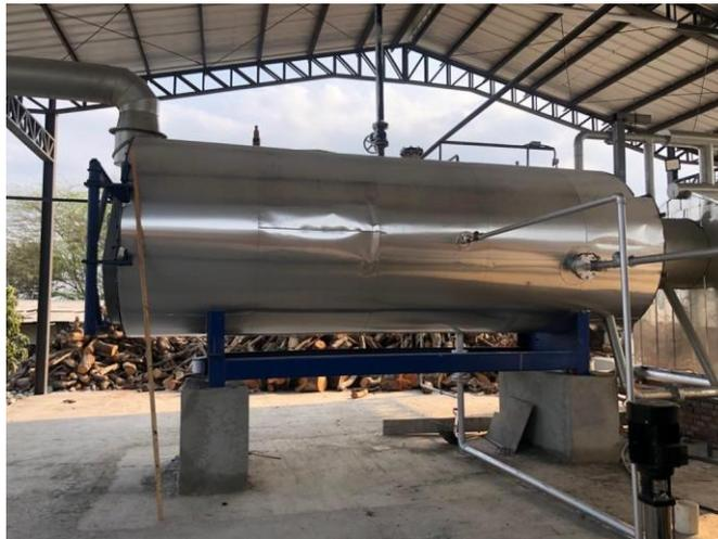
**Figura 2.4:** Sección pirotubular
