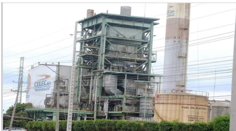
Figura 1-7: Central Térmica Esmeraldas
