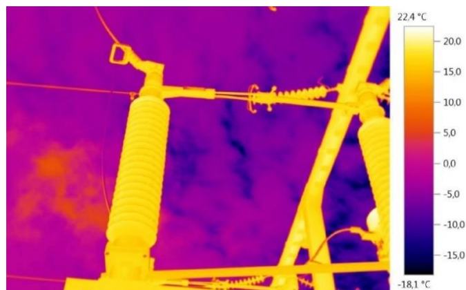
Figura 1.3 Termografía realizada en conexiones de alta tensión [7]
