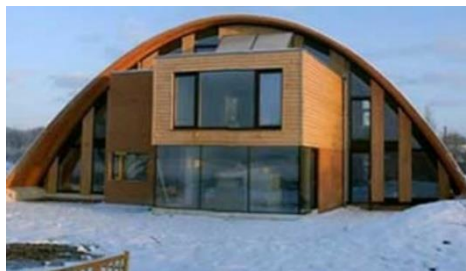
Figura 1.3 Vivienda abovedada para aplacar la fuerza del viento.
