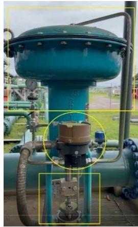
Figura 2.29. Actuador y conversor [Autores]
