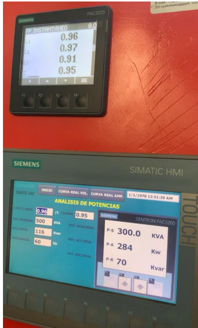
Figura 3-5 Potencias del sistema trifásico
