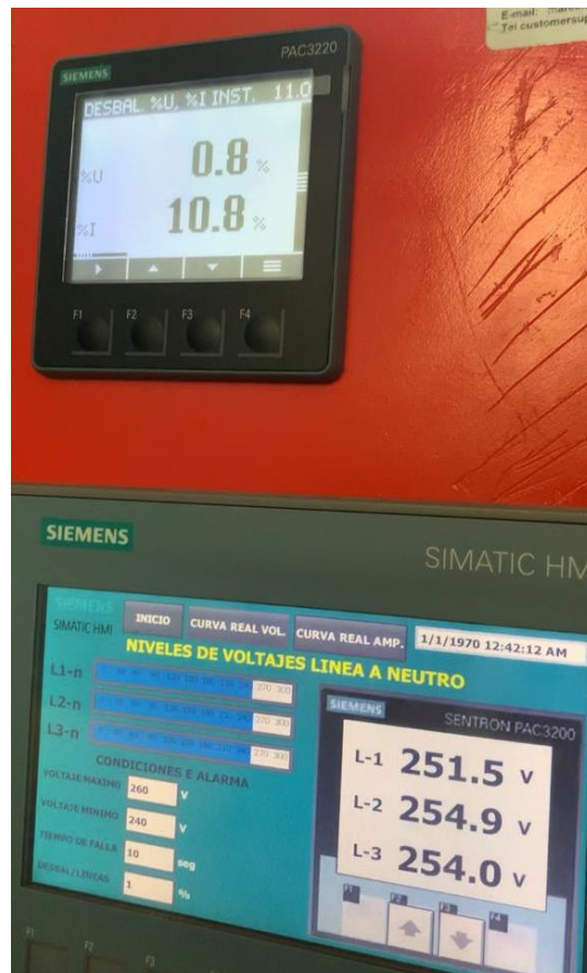
Figura 3-3 Niveles de voltaje línea – neutro
