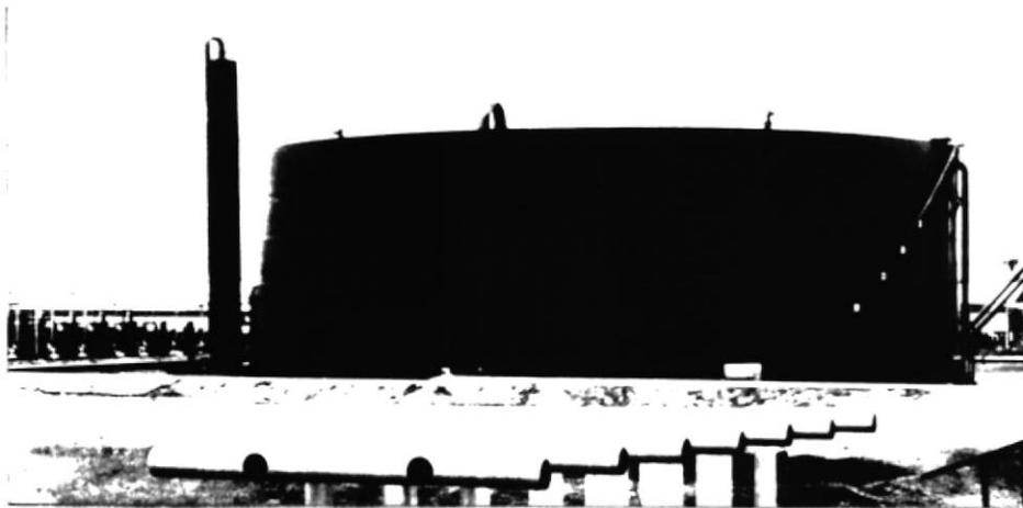
Fig. 3.8. Tanque de lavado.
