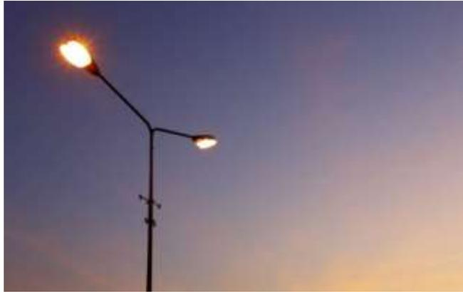
*Figura 1.2 Lámparas de vapor de sodio*
