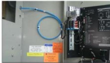
Figura 1.24 Sujeción de Cable de Red en equipos Modbus
