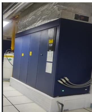
Figura 1.10 Unidad Manejadora de Aire Uniflair
