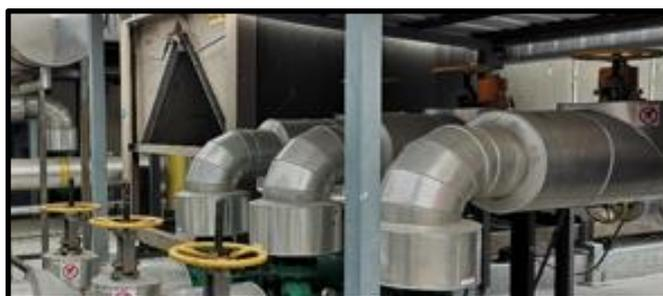
Figura 1.12 Chiller – Sistema Enfriamiento por Agua
