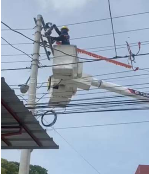
Figura 5. Instalación de Rocket-1
