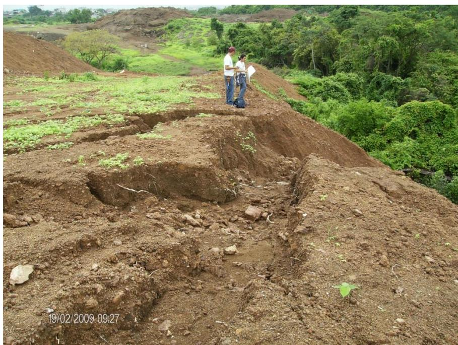
**Figura 5:** Erosiones provocadas por las antiguas canteras
