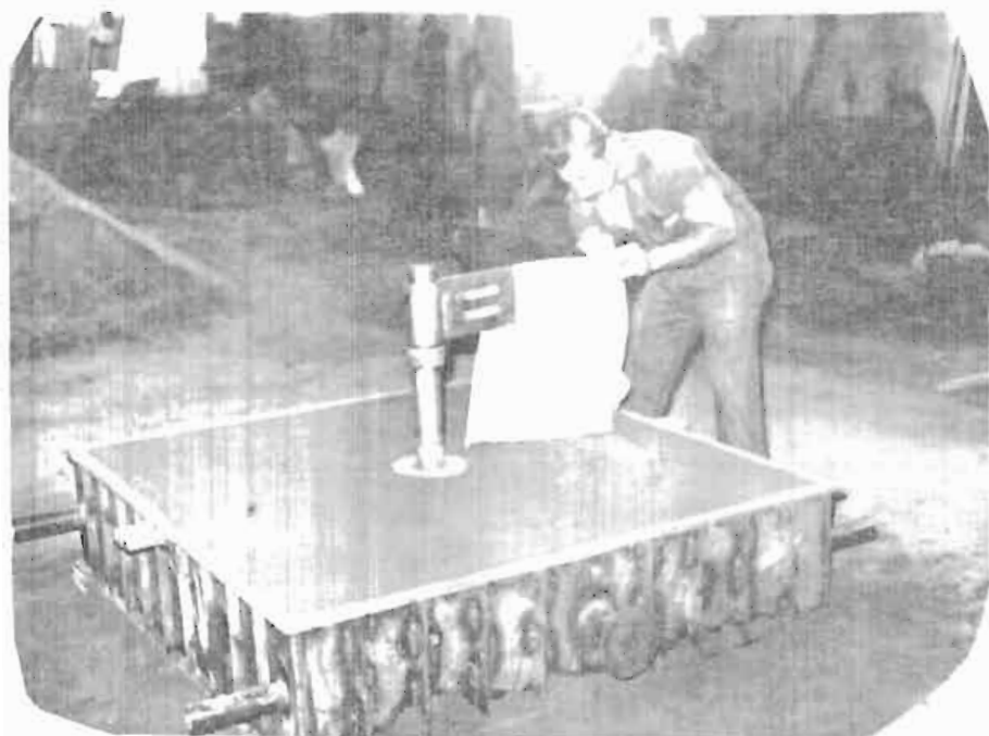
Figura No. 52 Inicio del Terrajado de los 360°
