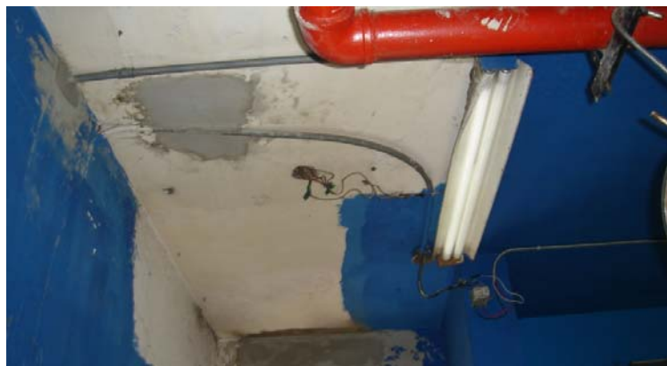
Fig. 5.9 Área de cocina del hospital de SOLCA
