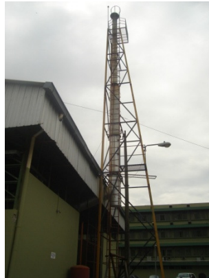
Fig. 1-15 Chimenea del Cuarto de Máquinas.
