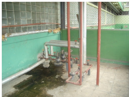
Fig. 1-16 Válvulas Reductoras de Presión.
