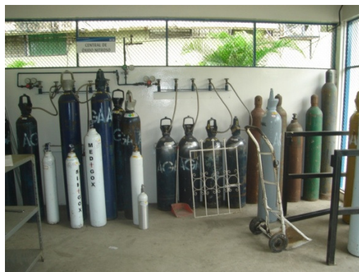
Fig. 1-3 Central de Óxido Nitroso.
