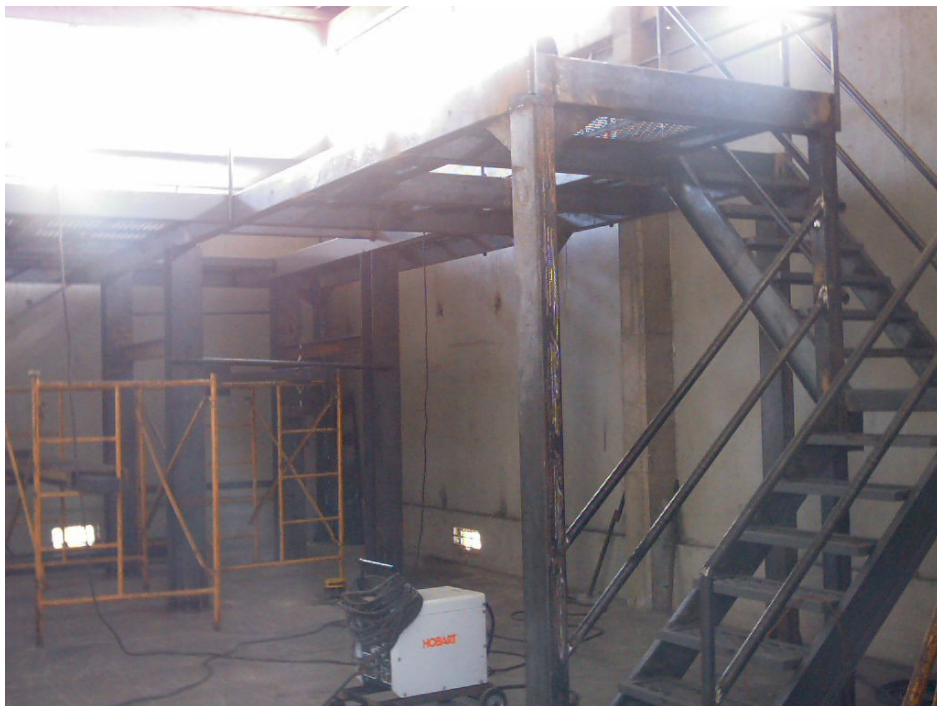
FIGURA 3.9. MONTAJE DE LA ESTRUCTURA PRINCIPAL.
