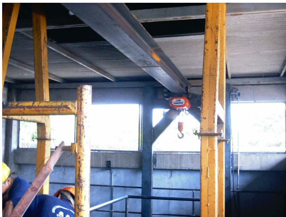
FIGURA 3.15. MONTAJE DE PUENTE GRUA.
