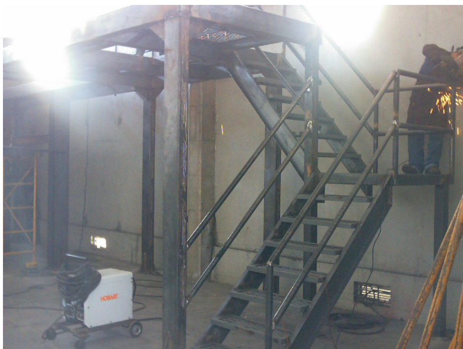
FIGURA 3.11 MONTAJE DE LA ESCALERA Y PASAMANOS.
