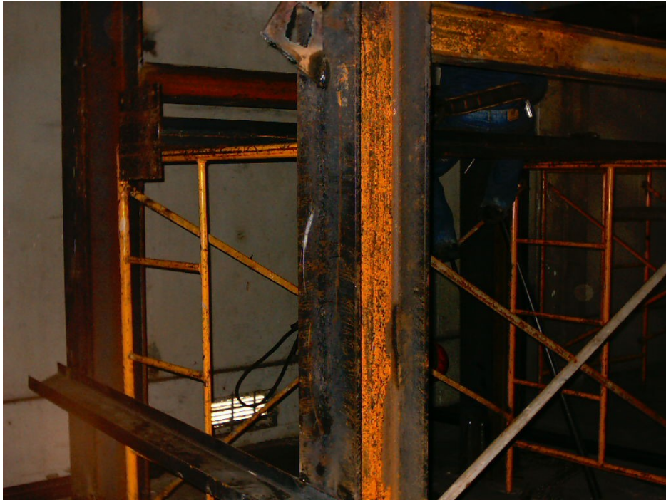
FIGURA 3.8. MONTAJE DE ESTRUCTURA SOPORTE DEL MEZCLADOR.
