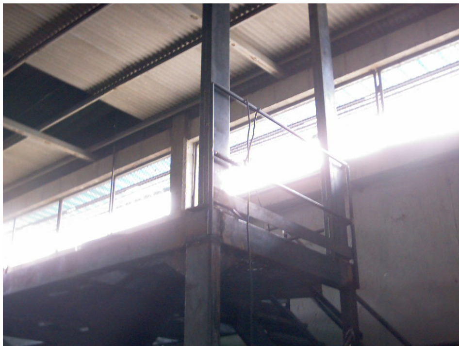
FIGURA 3.14. MONTAJE DE COLUMNAS PUENTE GRUA
