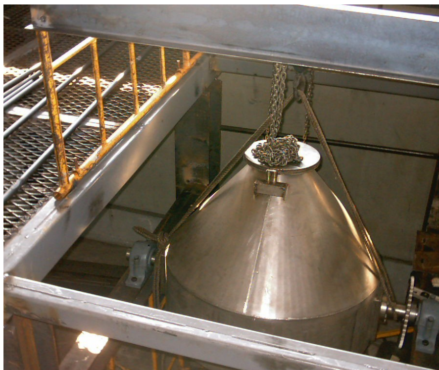
FIGURA 3.12. MONTAJE DE MEZCLADOR.
