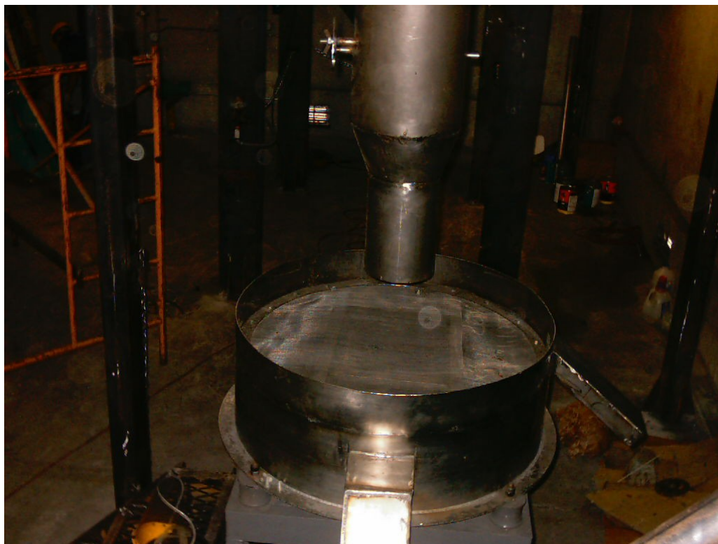
FIGURA 3.26. MONTAJE DE ZARANDA.
