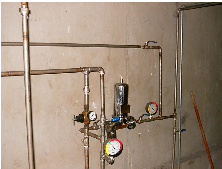
FIGURA 3.31. SISTEMA DE BOMBEO Y ATOMIZADO ENCENDIDO.
