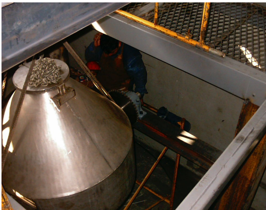
FIGURA 3.13. MONTAJE DE MEZCLADOR.
