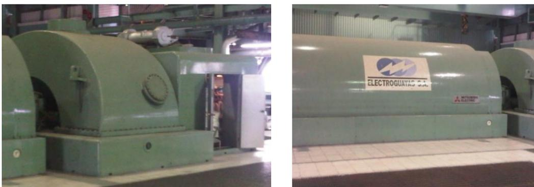
Figura 1.4 Acoplamiento Turbina-Generador
