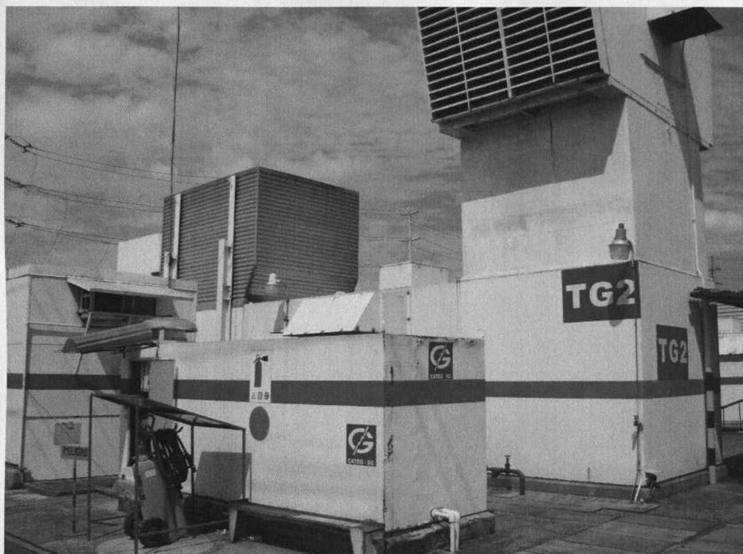
Fig. 3. Turbina a gas # 2, con capacidad máxima de generación de 21 MW, fue traída en Septiembre de 1974, Tensión de salida 13.600 V.
