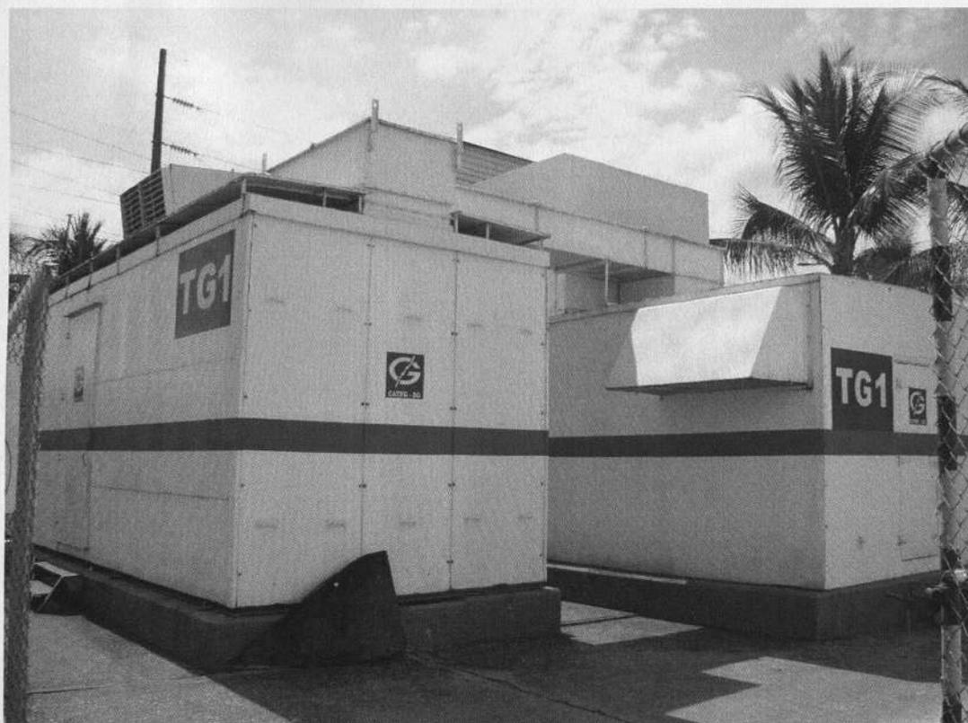
Fig. 2. Turbina a gas # 1, con capacidad máxima de generación de 21 MW, fue traída he instalada en Noviembre de 1972, Tensión de salida 13.600 V.
