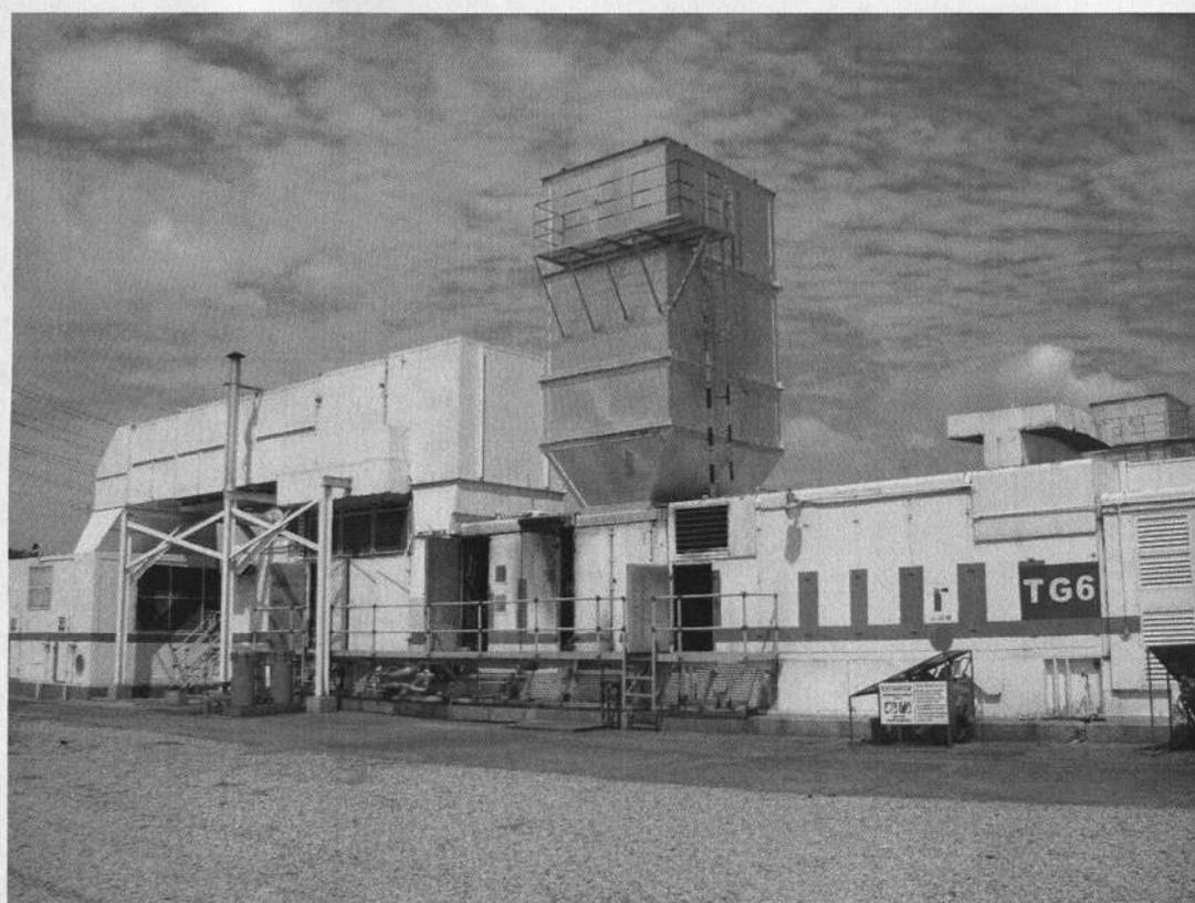
Fig. 6. Turbina a gas # 6, con capacidad máxima de generación de 24 MW, fue traída en Septiembre de 1978, Tensión de salida 13.000 V.
