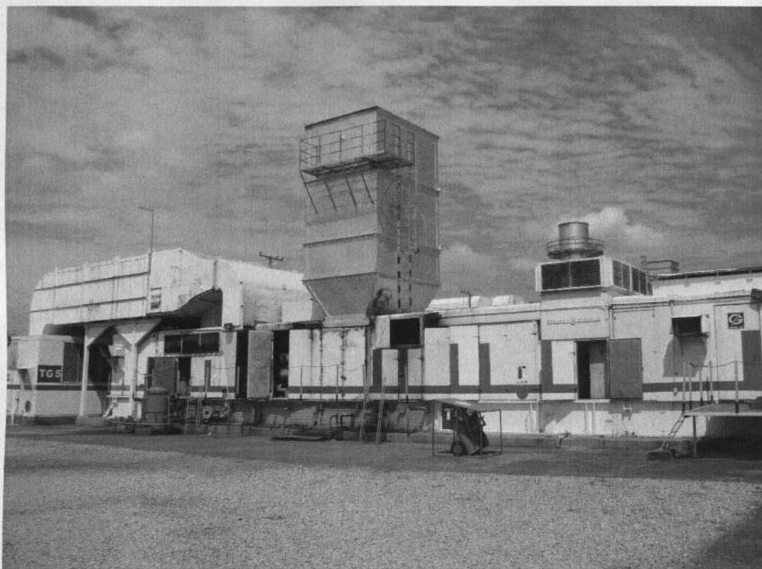
Fig. 5. Turbina a gas # 5, con capacidad máxima de generación de 24 MW, fue traída en Octubre de 1977, Tensión de salida 13.000 V.
