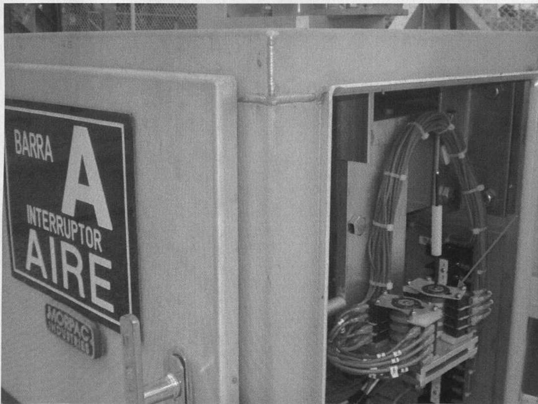
Fig. 16. Este es el Morpac que abre a una de las cuchillas ya sea de aire o de tierra, lo que esta señalado dentro de él es el mecanismo que calibra la carrera de apertura o cierre.
