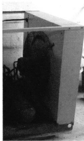
Fig. 5: Conjunto condensador y ventilador de la unidad de enfriamiento
