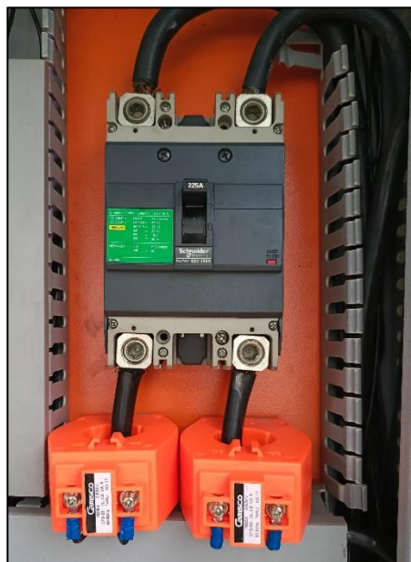
Figura 2.3. Conexión de CT's
