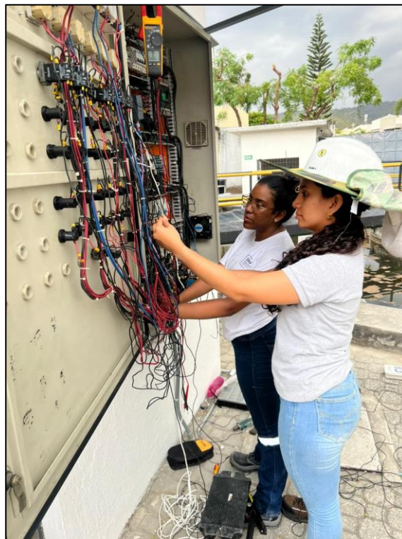
Figura 2.4. Retiro del cableado del tablero de control de la PTAR
