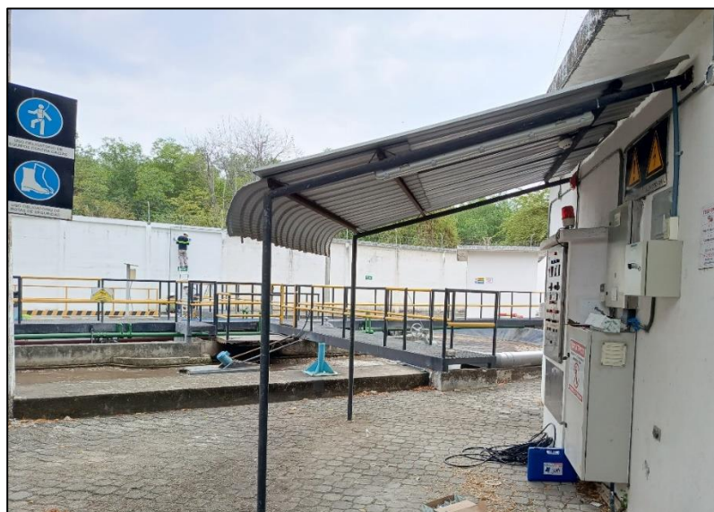
Figura 2.2. Planta de Tratamiento de Aguas Residuales
