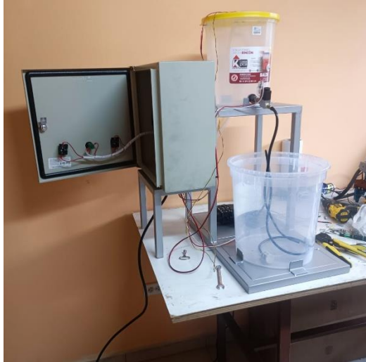
Figura. 3.7 Montaje de los elementos de la planta de fluidos
