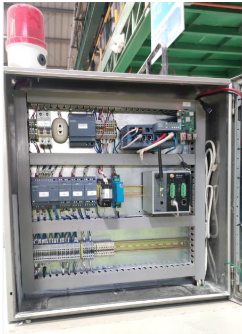
Figura 8: Tablero implementado en líneas de extrusión
