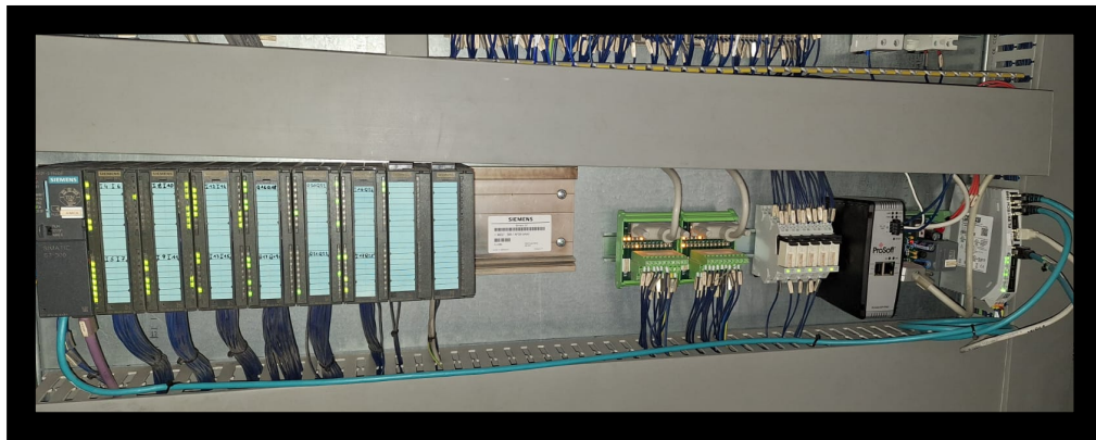
Figura 6.5. Instalación del Gateway EIP-PND
