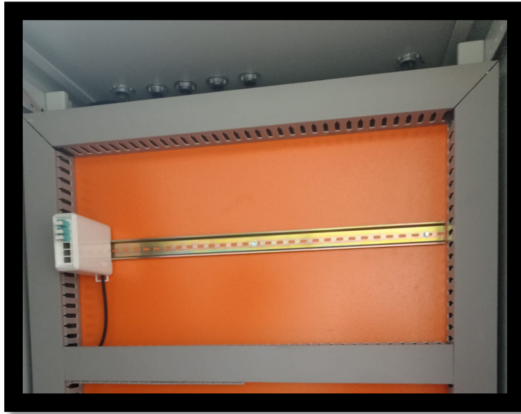
Figura 6.1. Plafón antes de la instalación del PLC concentrador
