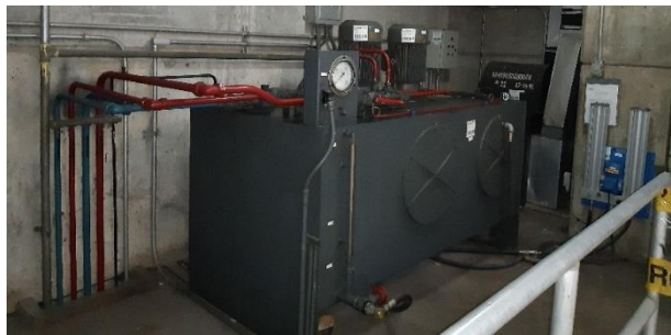
Figura 4.- Grupo Oleo hidráulico.
