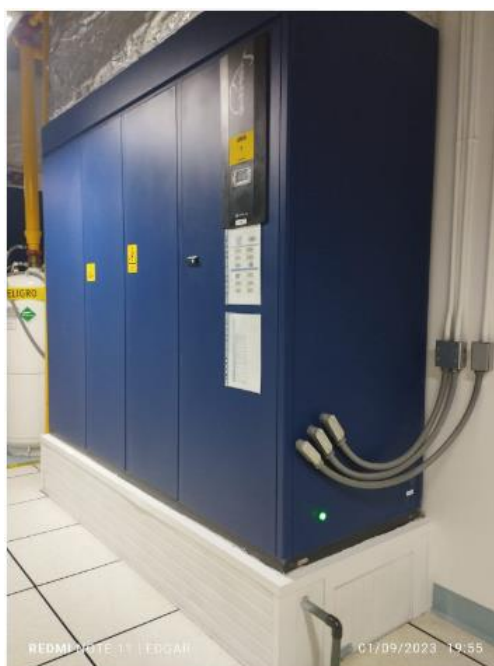
Figura 1.5 Unidad Manejadora de Aire por Agua
