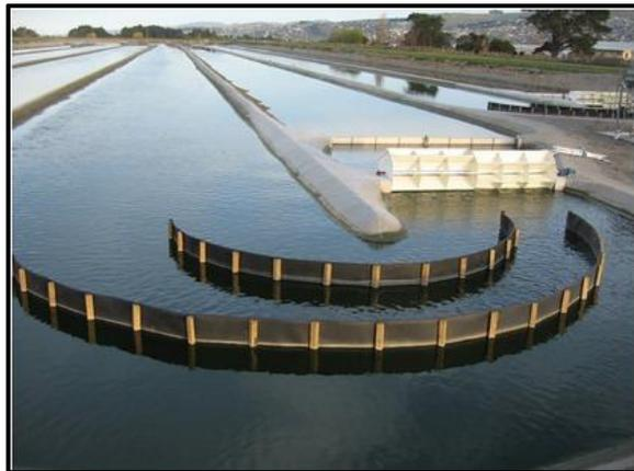
**Ilustración 20.** Diseño referencial de reactor HRAP.
