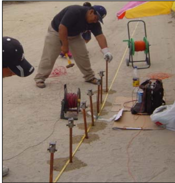
Foto. 4.3 Colocación de electrodos de cobre.
