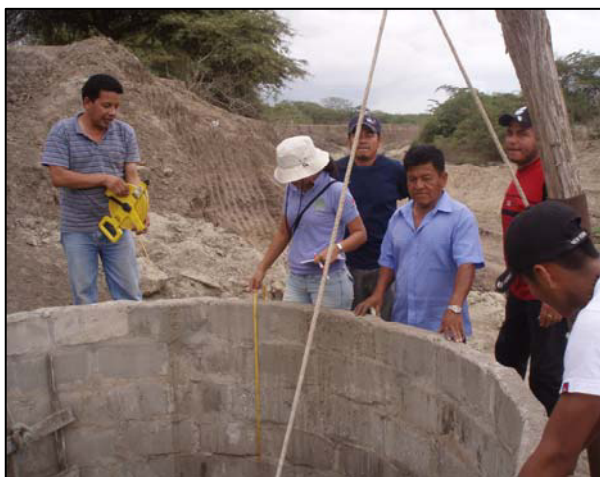
Foto. 4.1 Inventariado de pozos. Fuente: Jiménez S, 2007
