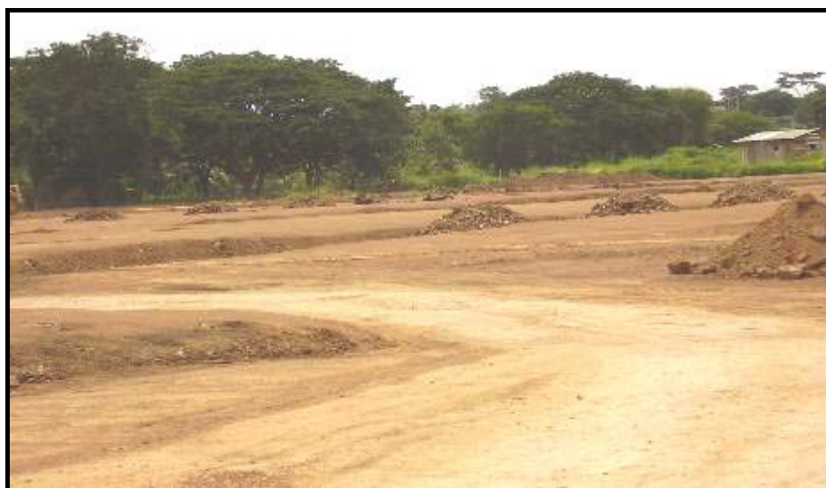
Figura 3.12 Área donde se ha reconfigurado el terreno para inicio del proyecto (111) .
