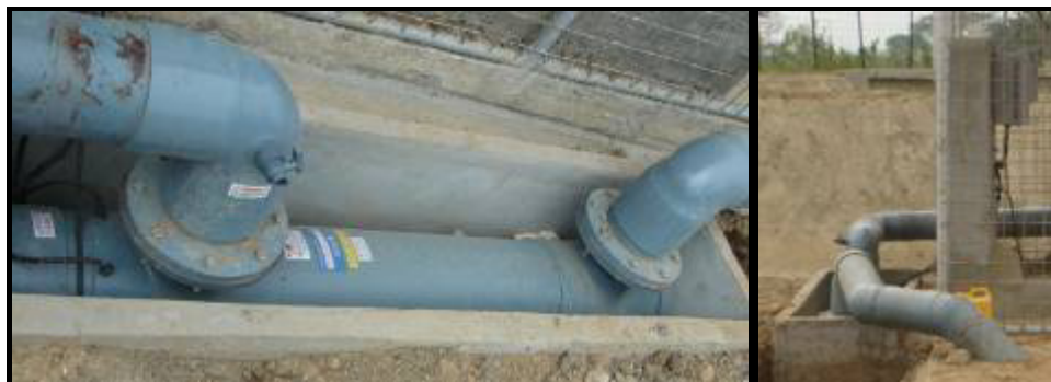
Figura 2.9 Construcción de la caja e Instalación del equipo de Desinfección de Rayos Ultravioleta (75) .
