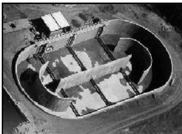
Figura 1.12 Tratamiento secundario: Zanjas de Oxidación (24) .
