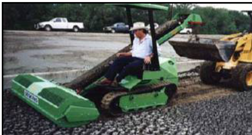
Figura 1.16 Lecho de secado pavimentado (28) .
