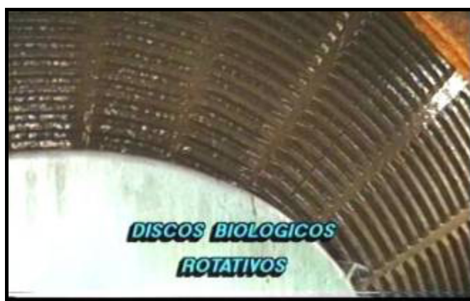
Figura 1.13 Tratamiento secundario: Bio discos (25) .
