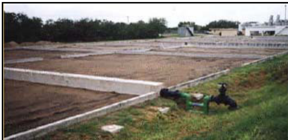
Figura 1.15 Lecho de Secado de Arena (27) .
