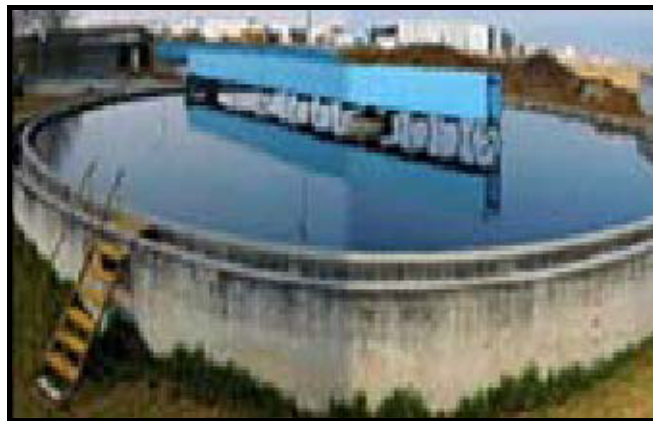
Figura 1.5 Tanque clarificador Secundario de forma circular (12) .
