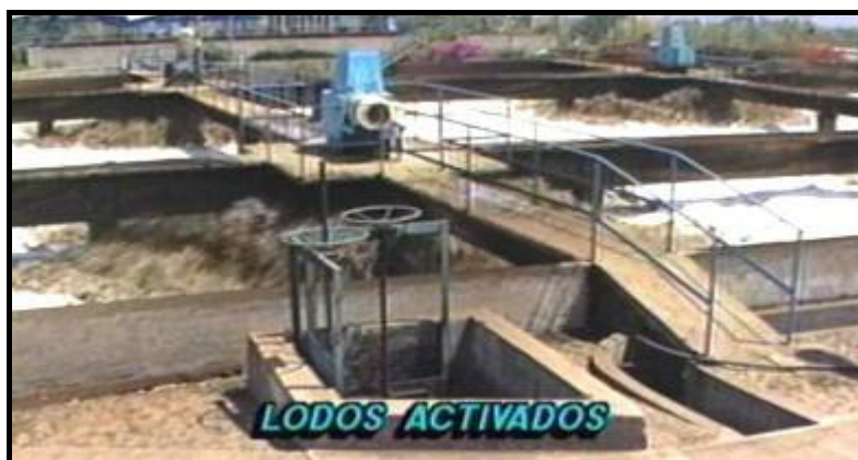
Figura 1.11 Tratamiento secundario: Lodos Activados (23) .
