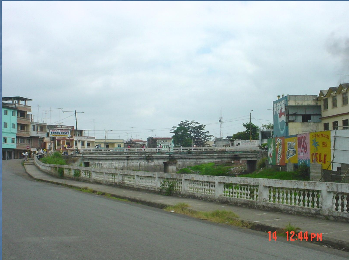
ACCESO AL PUENTE
