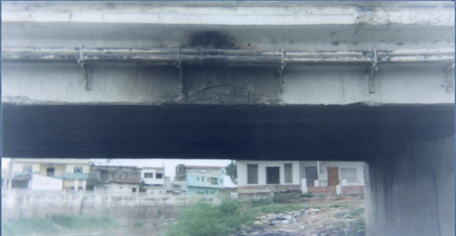
VIGA DE LA ESTRUCTURA ANTIGUA DEL PUENTE
