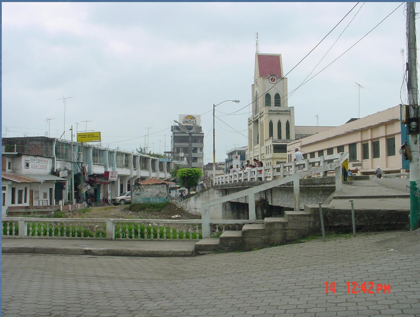
ACCESO AL PUENTE
