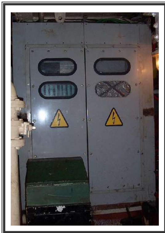
Figura No. 7.4 Caja de Bypass de Alimentación Principal
