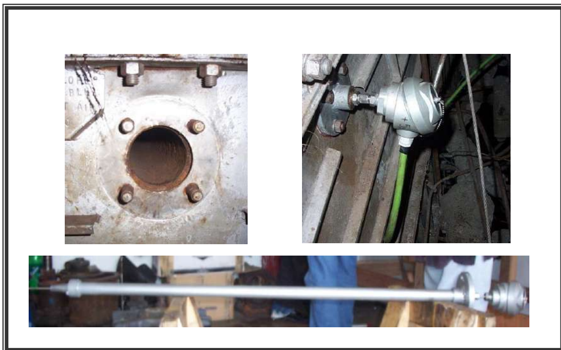
Figura No. 7.16 PT-100 para medición de temperatura de los gases de la caldera y su ubicación
