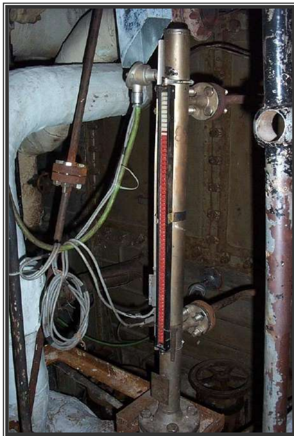
Figura No. 7.8 Medidor de Nivel tipo Bypass
