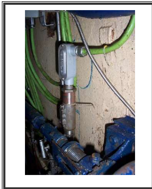
Figura No. 7.25 Transmisor de Presión para la descarga de agua de la Bomba de Alimentación Principal
