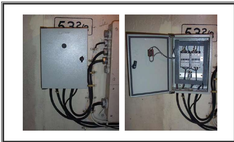
Figura No. 7.4 Caja de Bypass de Alimentación Principal
