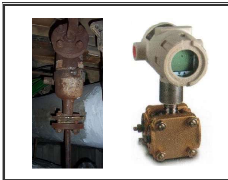
Figura No. 7.8 Medidor de Nivel tipo Bypass
