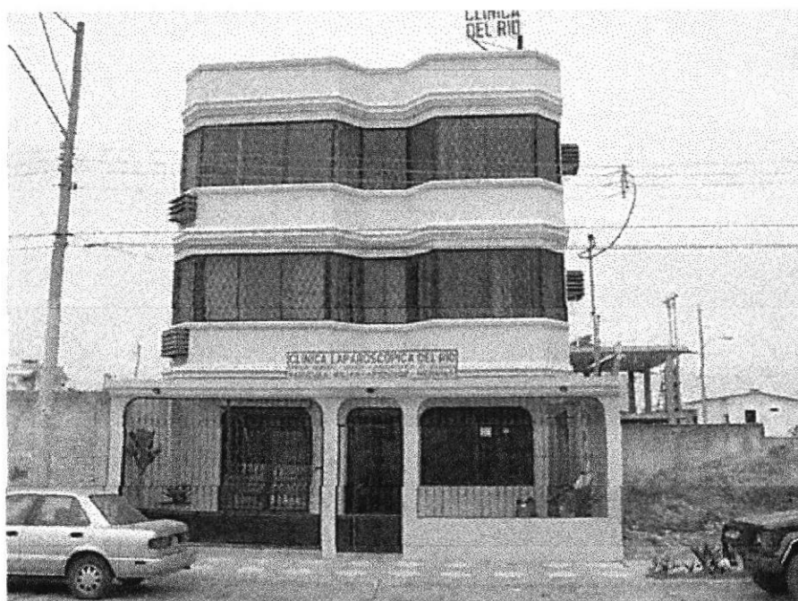
Figura 2.1 Edificio actual de la clínica
