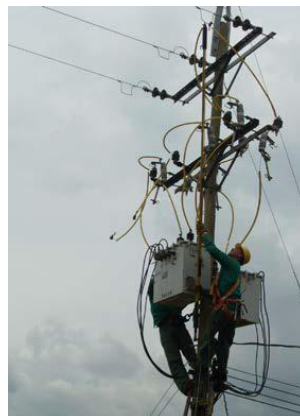
Figura 9. Instalación eléctrica para acometida de la bomba
