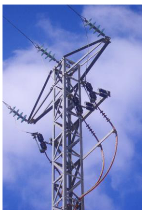
Figura 9. Instalación eléctrica para acometida de la bomba
