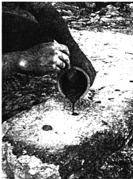
Foto 4.- Relleno de barrenos con argamasa expansiva.
