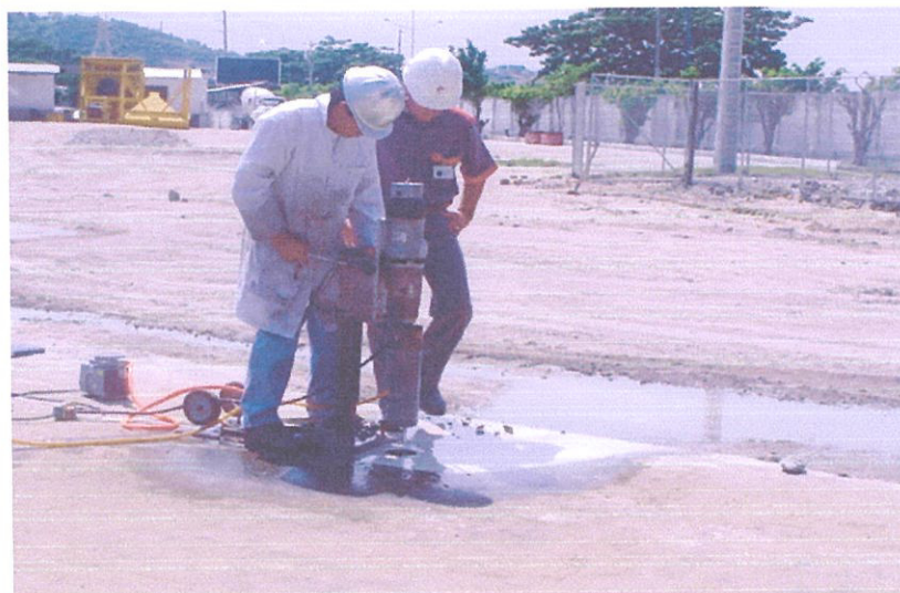
Foto 57 Taladro y broca de diamante
