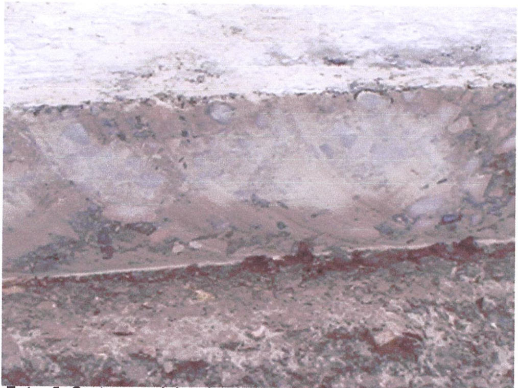
Foto 5 Corte en el borde de la base para colocar la faja siguiente
