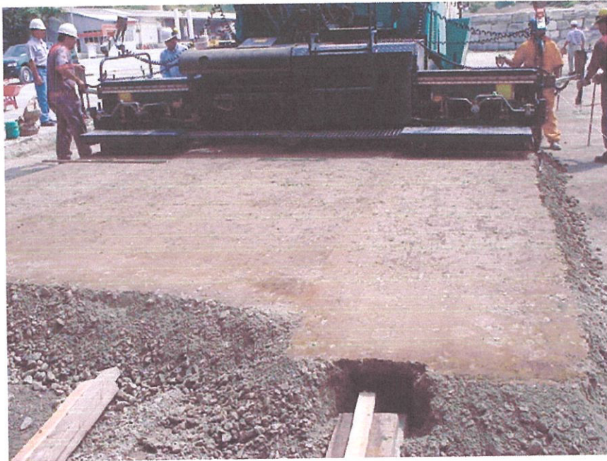
Foto 50 Inicio del tramo "a"
