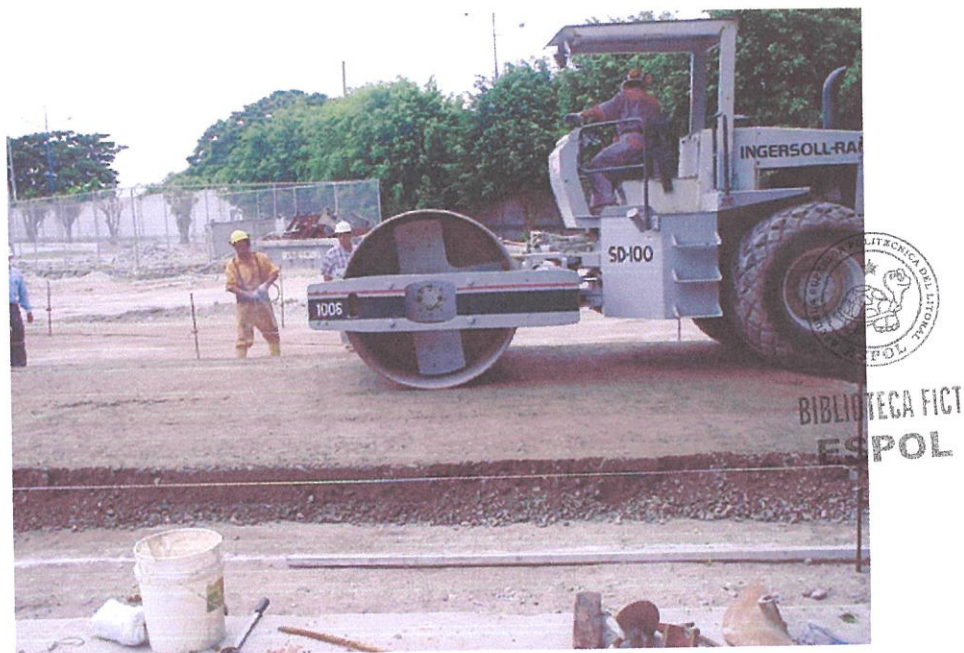
Foto 49 Compactación de la base de 30 cm de espesor
