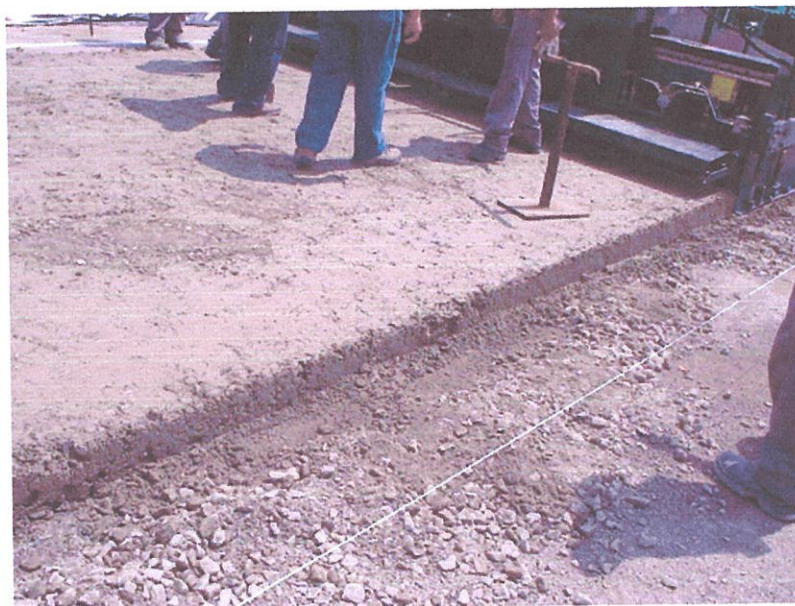
Foto 53 Bordes de base de 15 cm de espesor.
