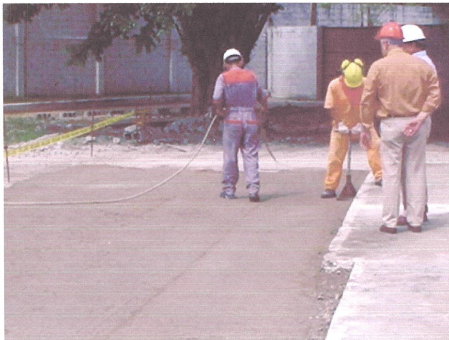
Foto 55 Compactación del sector de la junta longitudinal
