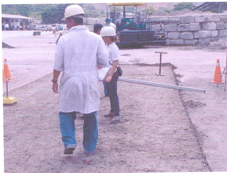
Foto 54 Prueba de densidad de campo
