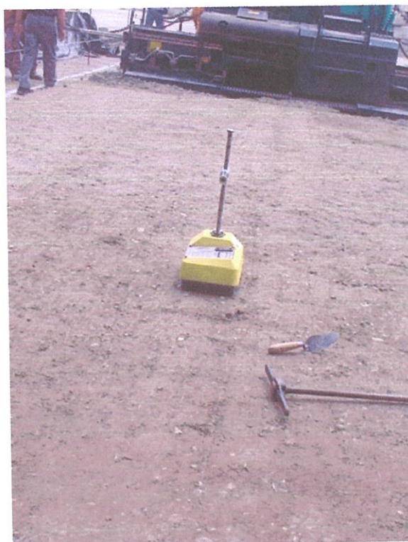
Foto 48 Prueba de densidad de campo.
