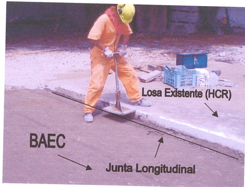
Foto 6 Compactación manual de junta longitudinal (borde)
