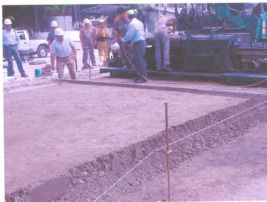
Foto 44 Verificación de planicidad transversal
