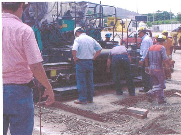
Foto 52 Tendido de base (15 cm de espesor).
