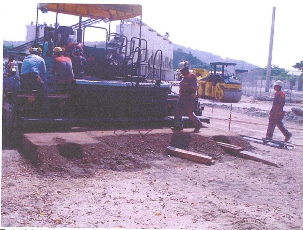
Foto 3 Inicio del tendido de la BAEC
