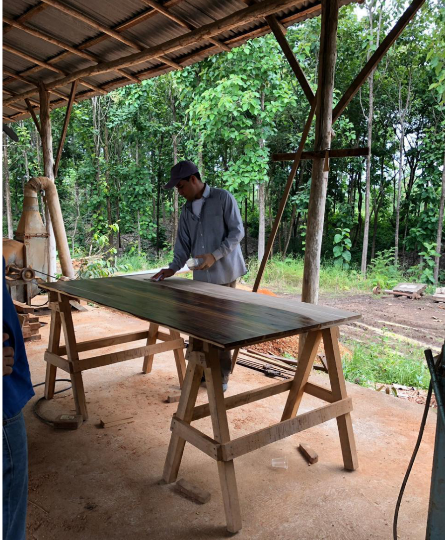
Ilustración 3-11. Pulido de tableros de listones de madera Fuente: los autores
