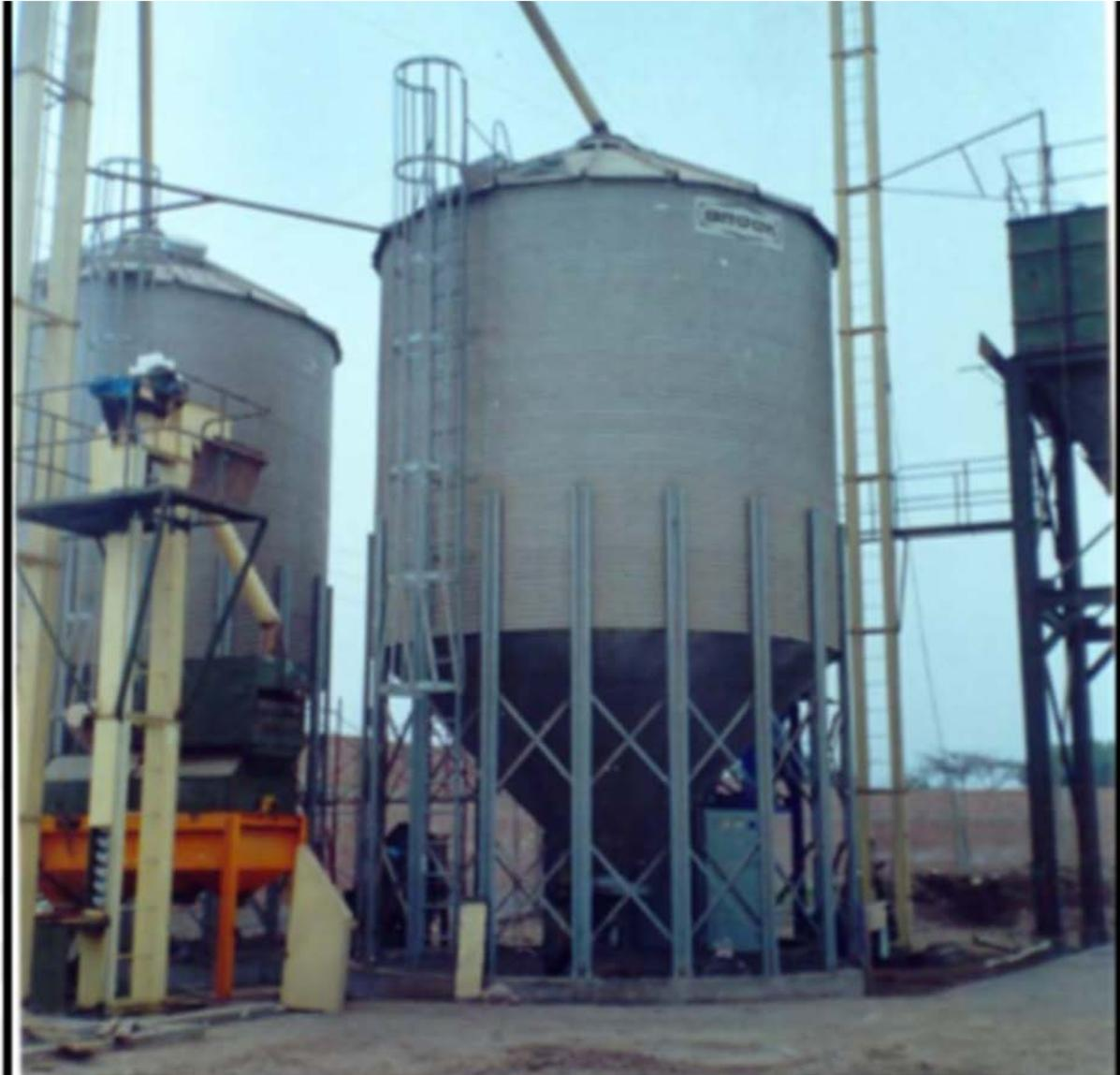
**Ilustración 3-1.** Silo cónico elevado para almacenar materias primas
