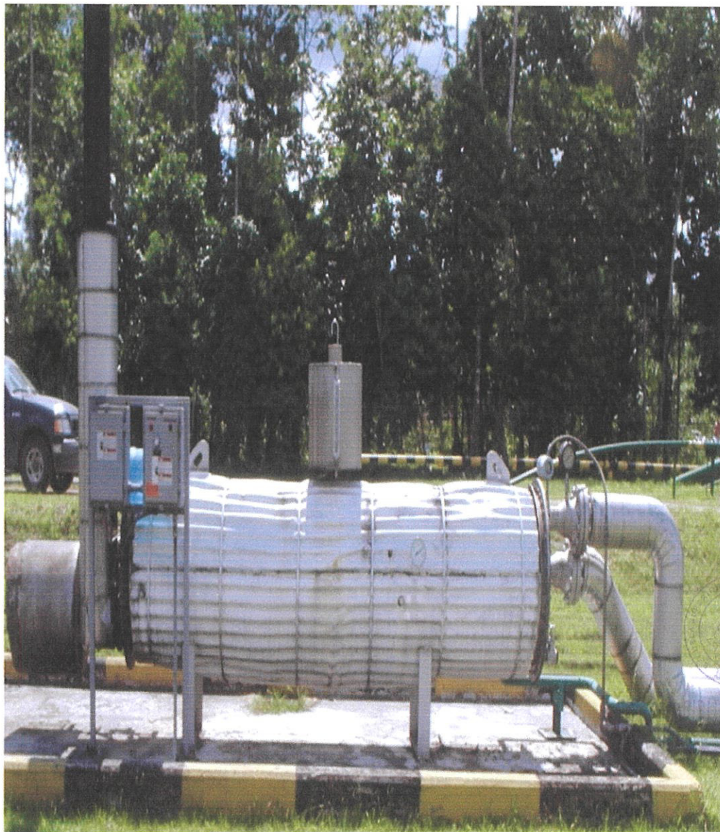
FIGURA 2.8. CALENTADOR EN LÍNEA (HT-10.01)
